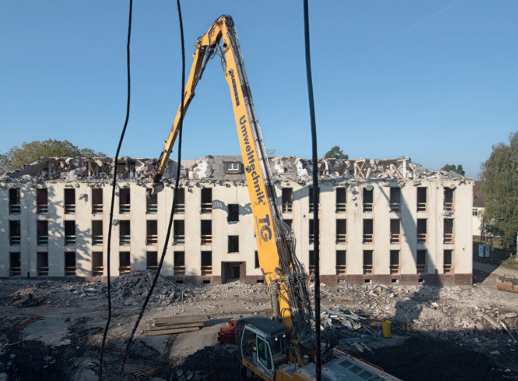
Drei Geschwister: Auf den Abriss der Dachgeschosse ...
