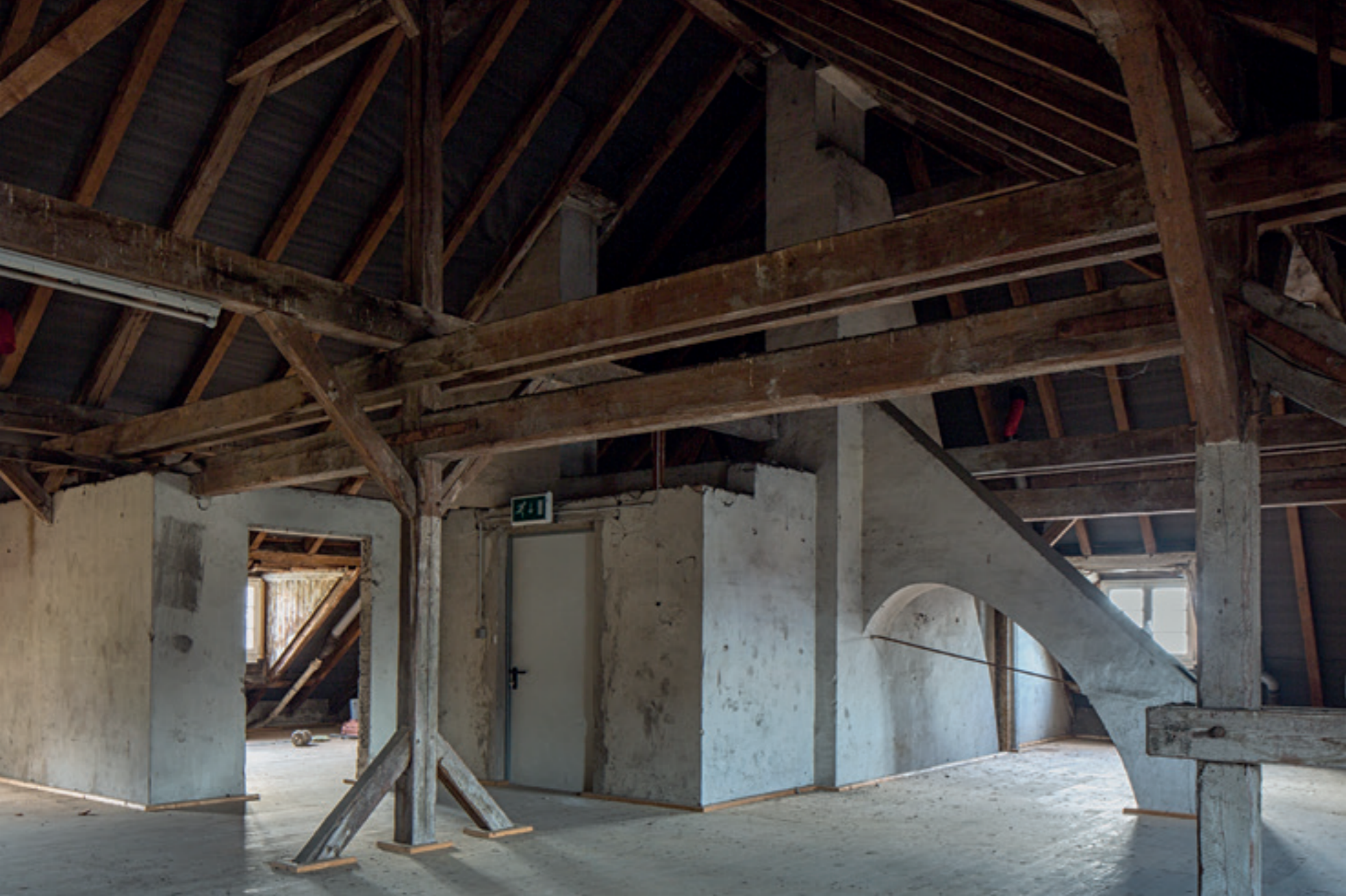
Aus der Serie „Spuren“: das Dachgeschoss von Gebäude F...
