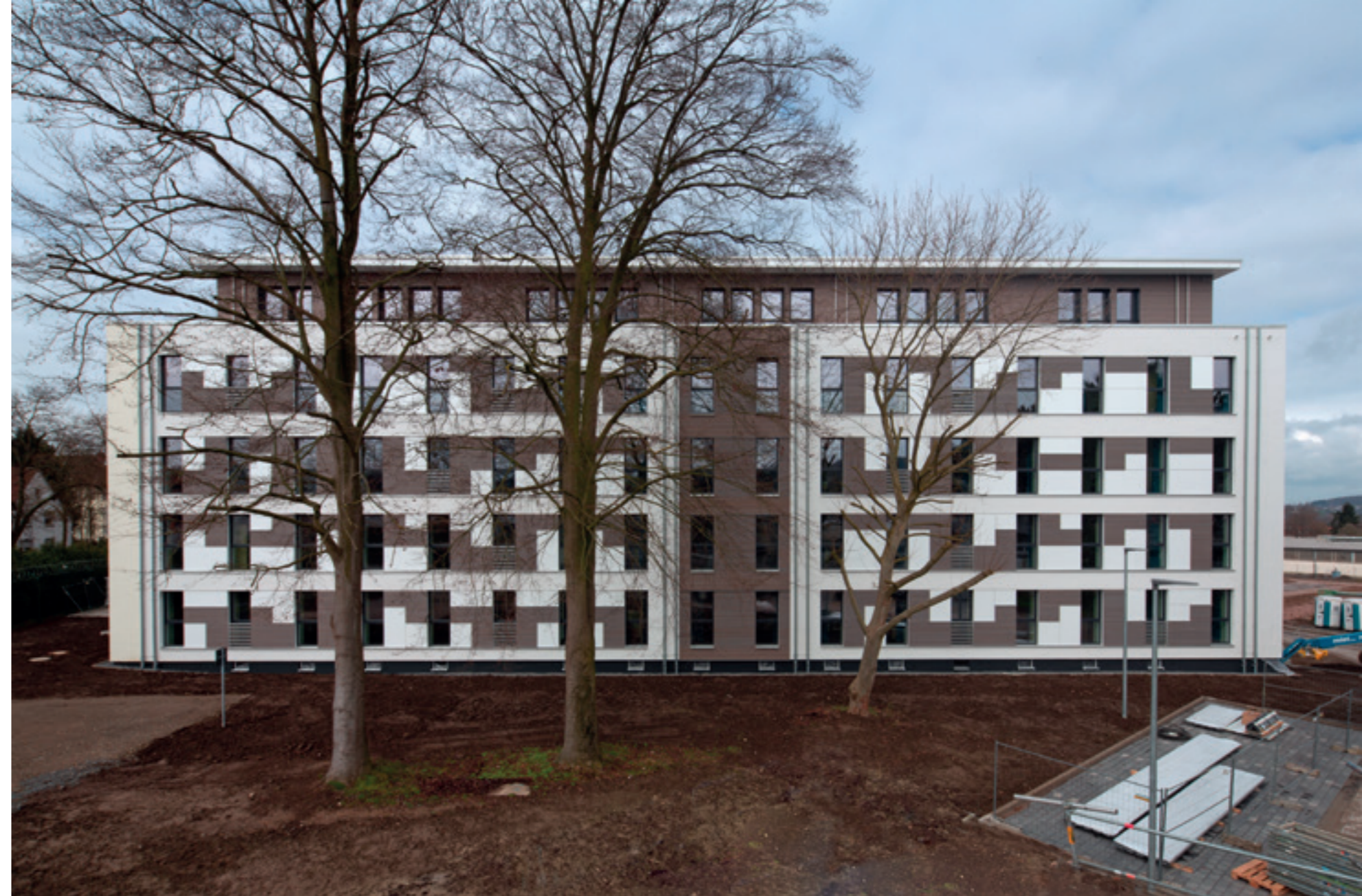
... folgte der Neubau zweier neuer Geschosse für Studierendenwohnungen.
